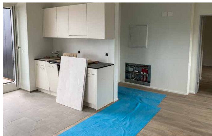
Die frisch renovierte Küche ist schon bald einsatzbereit.
