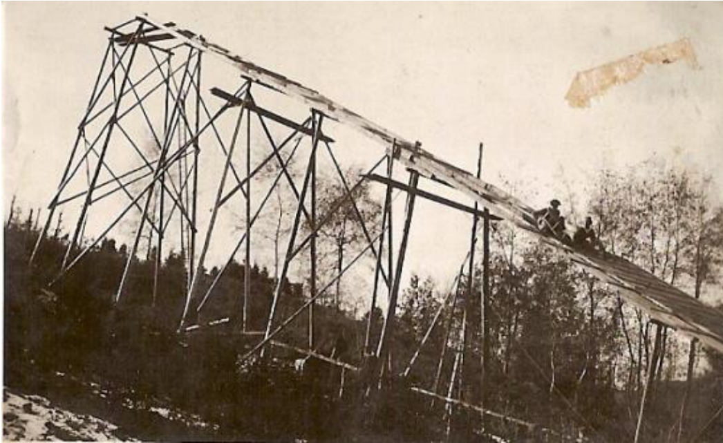
Abb. 106 1928: Vermutlich erste Aufnahme vom Bau des Anlaufturms. Freiwillige errichten mit Fantasie und Herzblut, aber ohne SUVA-Vorschriften, den ersten Anlaufturm. StadtASG
