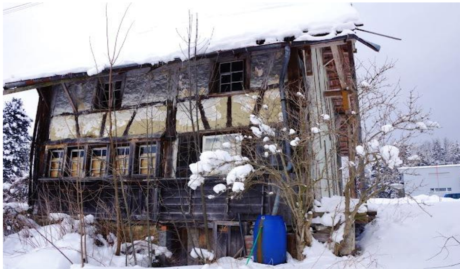
Abb. 13 2012: Kurz vor dem Abbruch eines der ältesten Häuser der Stadt (1706 erstmals erwähnt), Wattstrasse 15. Erich Gmünder
