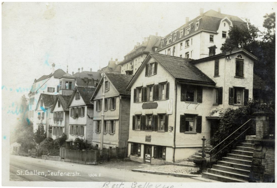
Abb. 117 Um 1929: Der Laden an der Teufener Strasse 99, im ersten Stock das Wirtshaus Bellevue . Man glaubt noch das Gebimmel der Ladenglocke zu hören beim Eintreten der Kundschaft. Rechts der Beginn der Scheffelstein-Treppe. StadtASG OBG
