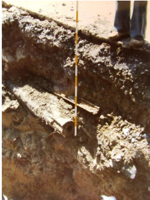
Abb. 72 1974: Die bei Bauarbeiten rund einen Meter unter dem Strassen-Niveau entdeckte hölzerne Wasserleitung (Teuchel) mit metallener Verbindungsmuffe. Franziska Knoll-Heitz, KBSG
