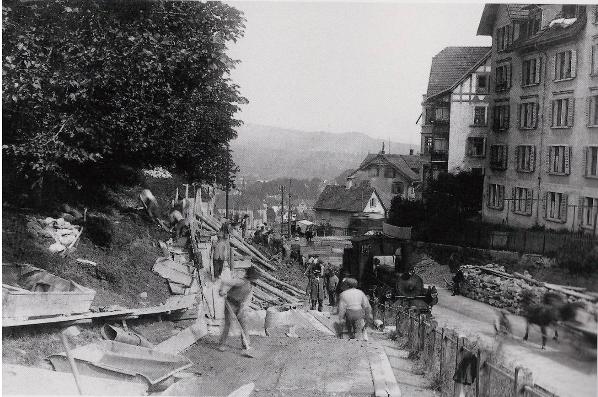
Abb. 101 1912: Strassenkorrektur zur Verbreiterung der Teufener Strasse auf der Höhe Solitüdenstrasse. In der Mitte im Hintergrund sieht man noch ein Tram der Linie 5 an der damaligen Endstation Hochwacht, ebenso den Vorgänger des heutigen Kioskes. StadtASG
