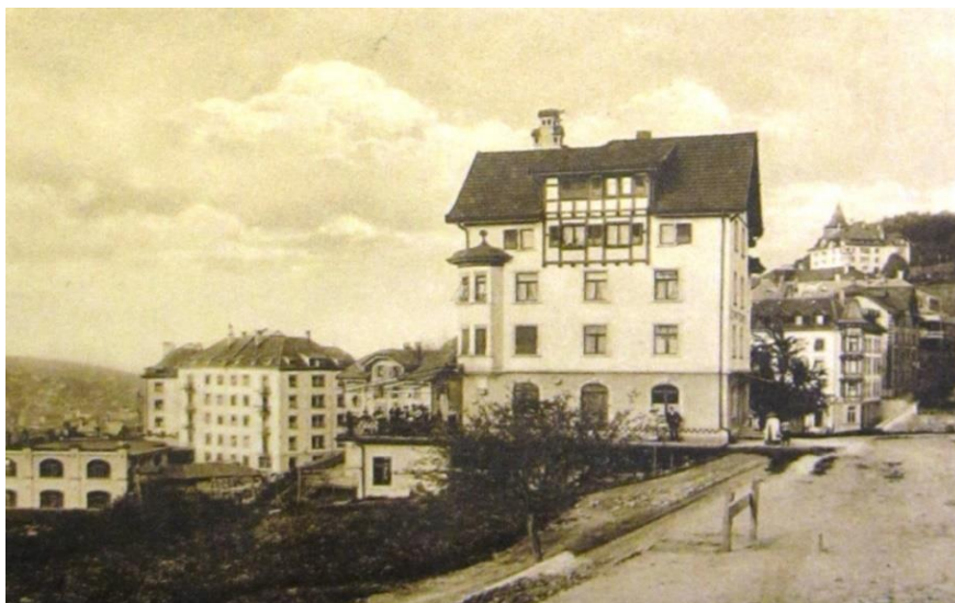
Abb. 10 Hochwachtstrasse um 1908: Noch ist die Strasse in einem provisorischen Zustand. 1906-1917 besteht das Wirtshaus Hochwacht (Abb. 134) mit der Sonnenterrasse. StadtASG
