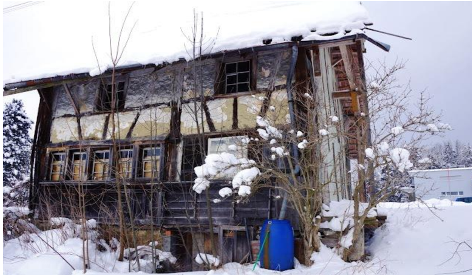
Abb. 13 2012: Kurz vor dem Abbruch eines der ältesten Häuser der Stadt (1706 erstmals erwähnt), Wattstrasse 15. Erich Gmünder
