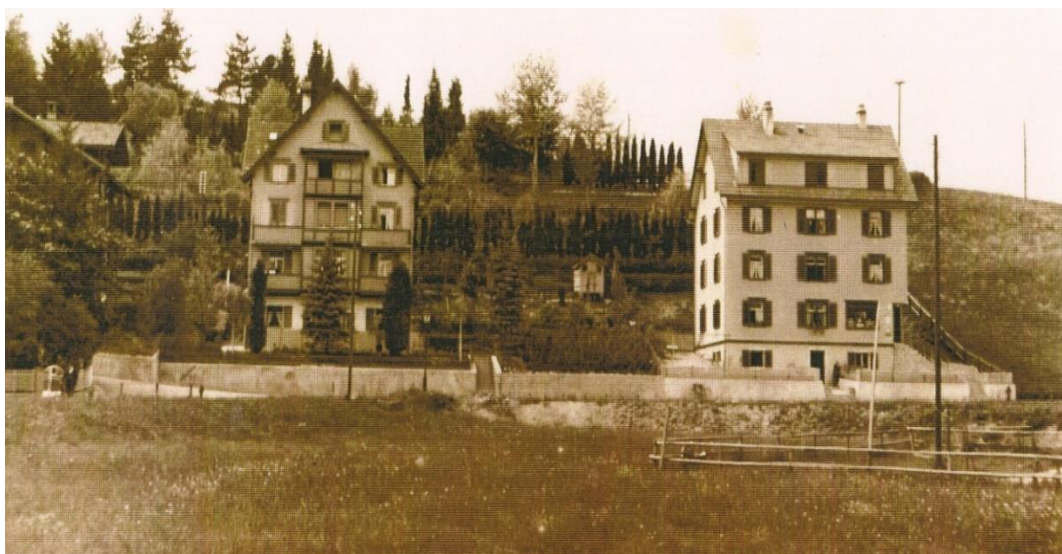
Abb. 116 Um 1930: So sah ein Quartierladen zu dieser Zeit aus. Konrad Künzler führte ein Obst- und Delikatessen-Laden im Haus rechts im ersten Stock, Im Grund 6. Noldi Duttweiler
