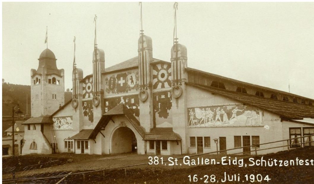
Abb. 21 1904: Postkarte vom Eidgenössischen Schützenfest im Tal der Demut. Mehrere solcher Monumentalbauten wurden errichtet – und bis auf einen wieder abgebrochen. StadtASG
