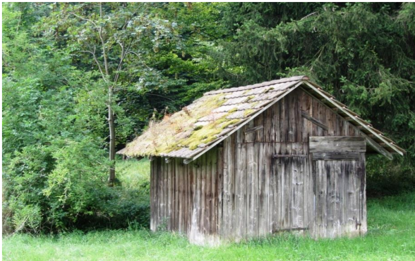
Abb. 9 2015: Dieser verträumte Stadel steht 50 Meter neben der zweitmeist befahrenen Kantonsstrasse auf der Wiese beim Auslauf der ehemaligen Sprungschanze. Das Verkehrsaufkommen soll in Spitzenzeiten hier täglich durchschnittlich bis zu 18'900 Fahrzeugen betragen (→ 1 Teufener Strasse in Zahlen).
