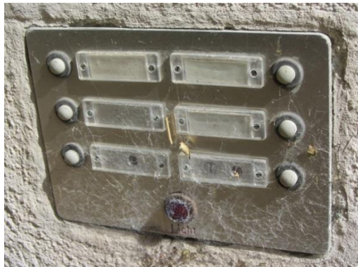
Abb. 197 Im Grund 10a und 12a: Hier wohnten einst in den zwei Doppel-Wohnblöcken 24 Parteien. Zieht neues Leben ein?
