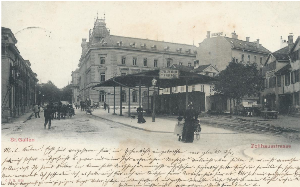
Abb. 98 Vor 1900: Der alter Gaiserbahnhof bis 1914, im Hintergrund das damalige Rathaus , dazwischen die hier unsichtbare Drehscheibe, Mitte rechts das Wirtshaus Bierquelle als Bahnstation mit Billettschalter , links das damalige Zollgebäude (siehe Stadtplan 1903). Peter Uhler
