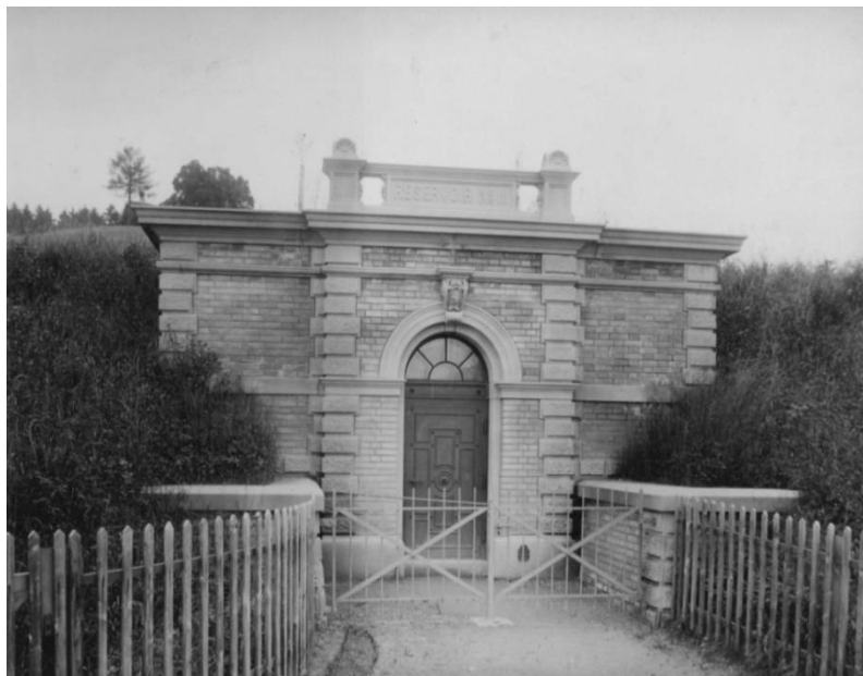
Abb. 66 1891: Das Eingangsportal des fertiggestellten Reservoirs Nest an der Oberen Berneggstrasse. Auf dem Dach erstellte die Stadt 2016 einen neuen Spielplatz (Abb. 93). StadtASG
