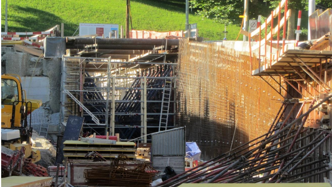
Abb. 167 Herbst 2016: Mit Hochdruck wird das südliche Tunnelportal bei der Busendstation im Riethüsli vorbereitet.
