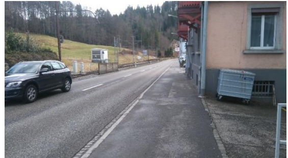
Teufener Strasse südwärts, Eindolung liegt unter Trottoir
