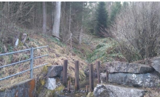
Rechen Oberhofstettenbach (gegen Fließrichtung)
