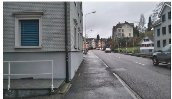
Teufener Strasse nordwärts, Eindolung liegt unter Trottoir
