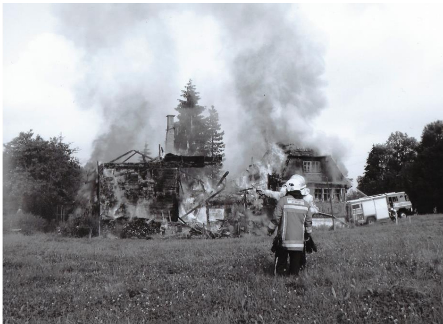
Abb. 12 2003: Letzter Brand vor der Räumung, Wattstrasse Nr. 10-16.
