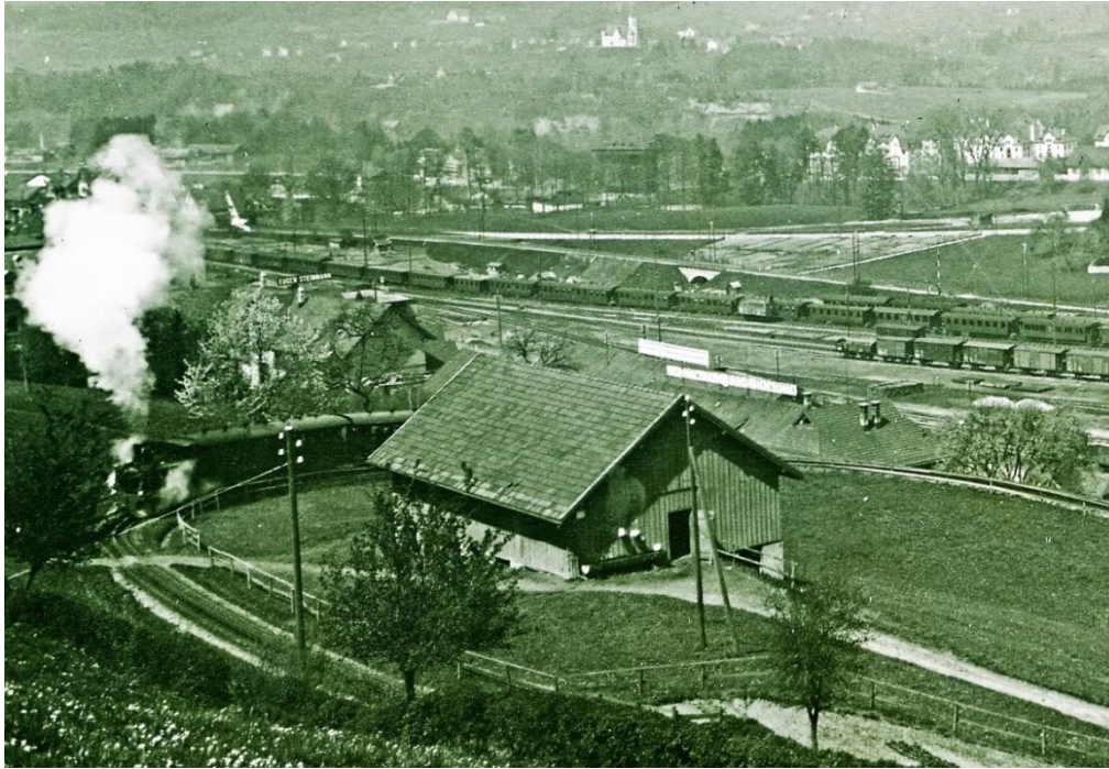
Abb. 50 um 1920: Der Stall im Ruckhaldenrank existierte von etwa 1910 bis 1972 und war für einige Jahre der 'illegale' Wohnsitz von → 9 Johann Rotach. Bis zum Tunnelbau 2016 war der Stall-Brunnen noch vorhanden. Willi Müller
