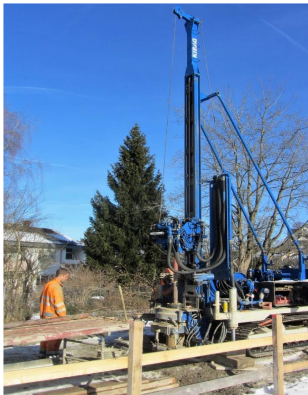
Abb. 76 Januar 2016: Die Quelle Hofstettenwasser auf der Spielwiese beim Schulhaus wird angebohrt und wie vor 545 Jahren gefasst und umgeleitet.
