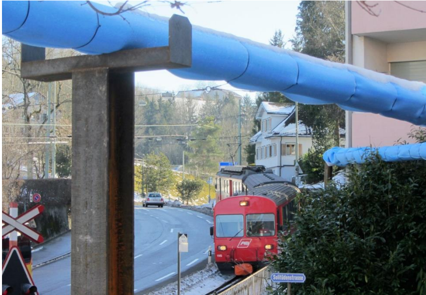
Abb. 75 Januar 2016, Absenkung des Grundwasserspiegels: Umleitung des sog. Hofstettenwassers anlässlich des Eisenbahntunnelbaus bei der Solitüdenstrasse.
